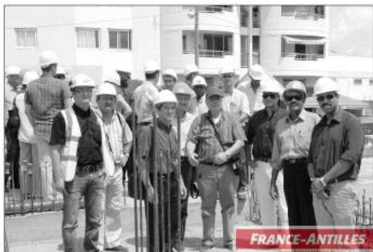
Les professionnels du Cobaty ont pu se rendre compte sur place de l'importance des travaux de fondation. (Wilfrid Tereau/France-Antilles)
