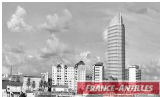
Avec 93 mètres de hauteur pour 21 étages, l'une des trois tours en construction sera la plus haute des petites Antilles.
